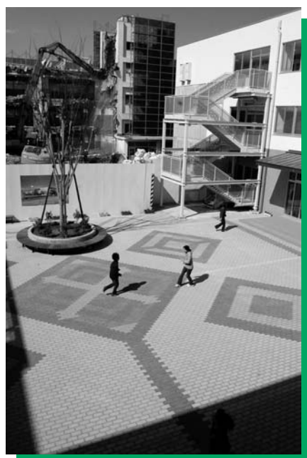
引き続き旧校舎の解体が進む第一小学校
