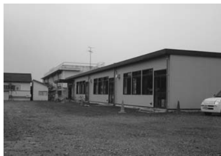
軽量鉄骨で増設した南清小学校
