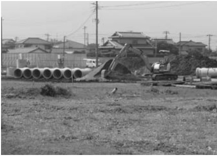
工事中の金田東地区
