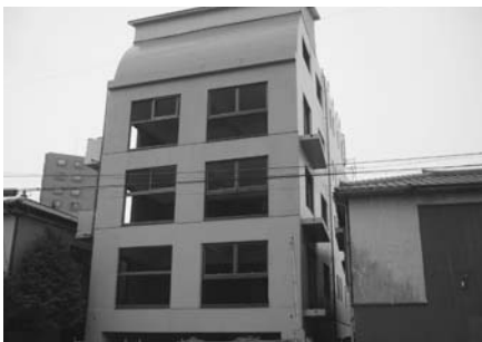
工事中で中断している建築物
