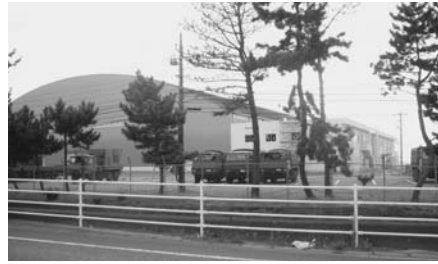
野整備格納庫
