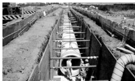
金田地区で進む下水道工事
