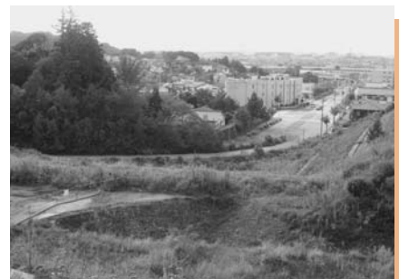
請西地区から見る草敷潮見線工事箇所
